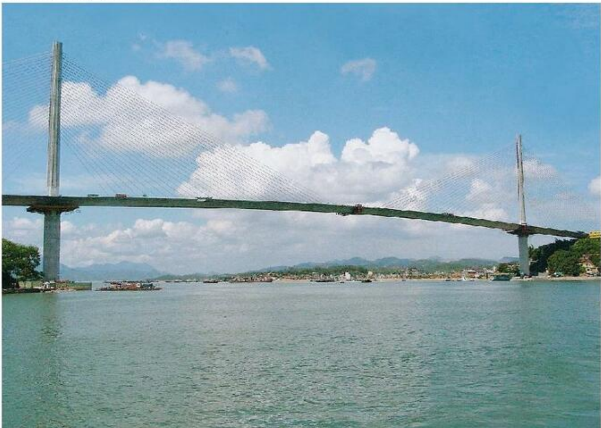
Cầu Bãi Cháy (Quảng Ninh)
